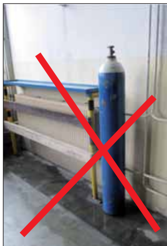
Příklad nesprávné manipulace – tlaková láhev nezajištěná proti pádu a umístěná u topného tělesa
